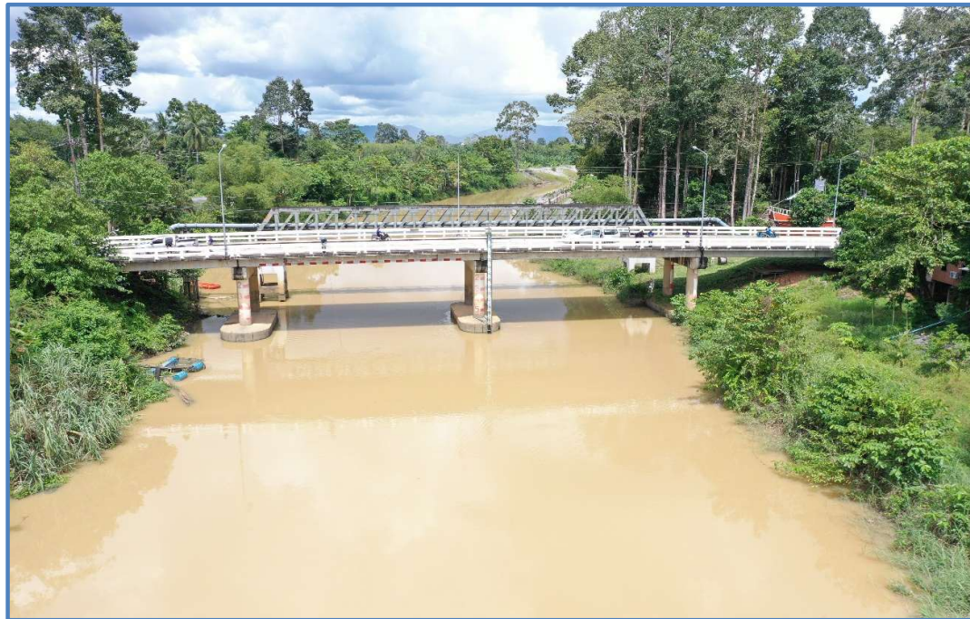
รูปที่11 สถานี X.234 แม่น้ำตรัง บ้านป่าหมาก อ.เมือง จ.ตรัง ที่ใช้เป็นดัชนีในการประเมินผลกระทบจากการกีดเซาะและการตกตะกอน ท้ายโครงการก่อสร้าง ประตุระบายน้ำแม่น้ำตรัง
